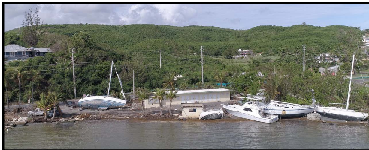
Daños en Barrio Sardinera , Fajardo
